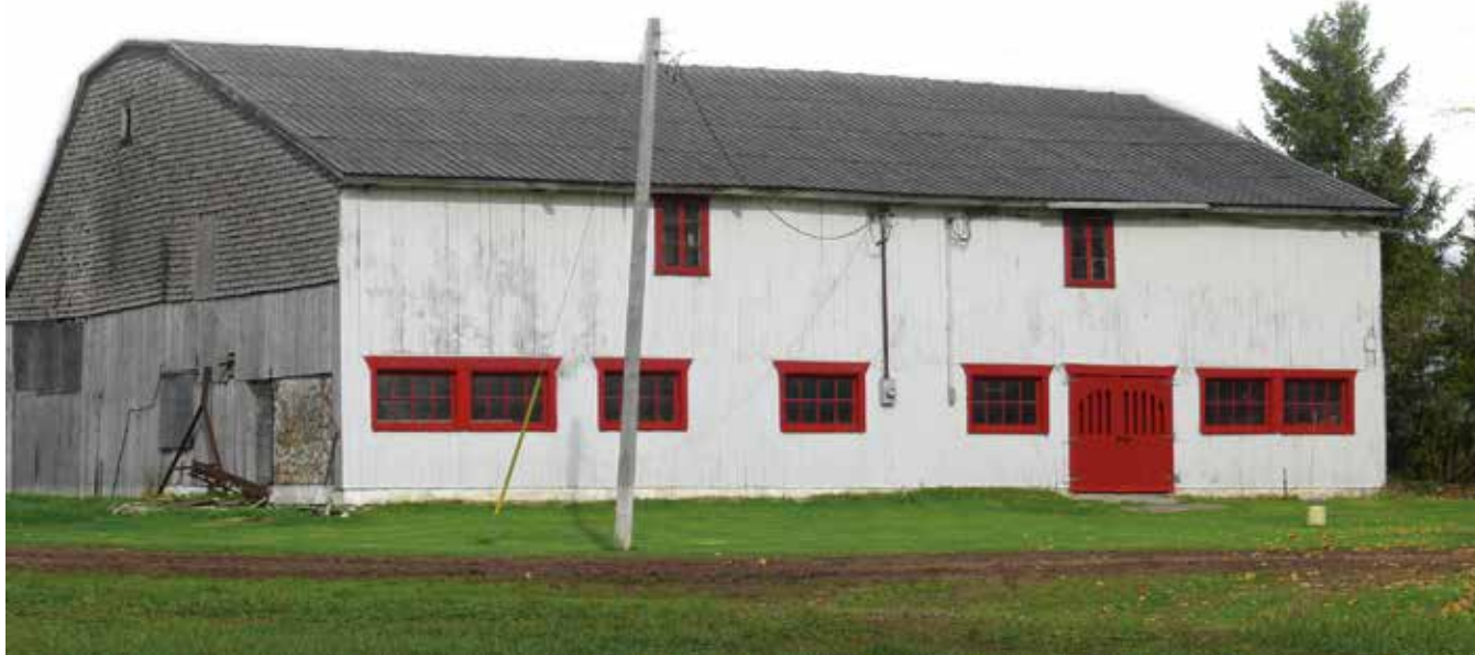
Grange-étable à Saint-Édouard-de-Lotbinière
