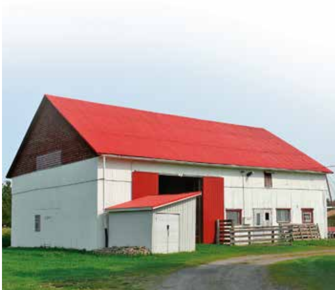
Grange-étable à Laurier-Station
