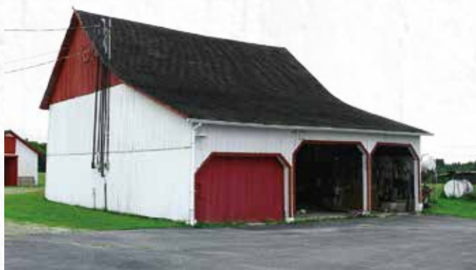
Hangar à Saint-Sylvestre
