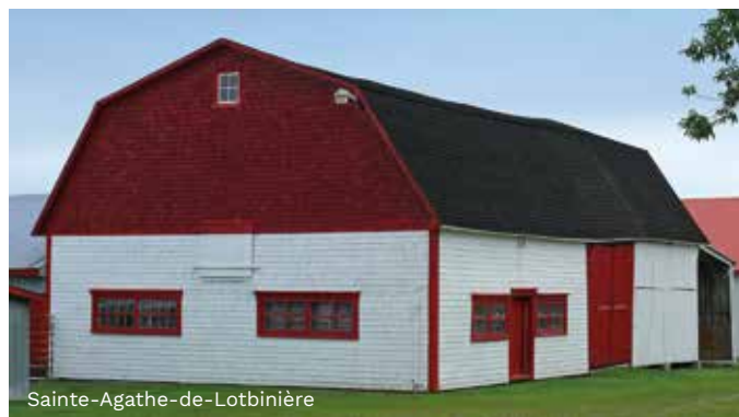
Grange-étable à toit brisé. Le profil bas de la grange et la forme évasée de la toiture témoignent de l'ancienneté de ce bâtiment bien entretenu.
