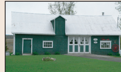
Forge Demers située au 305, rue Principale
