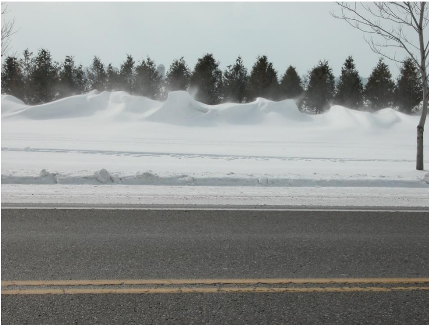
Exemple 1 d'accumulation contrôlée de neige en bordure d'une route grâce à une haie brise-vent
